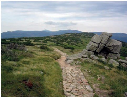
Obr. 14. Cesta od rozcestí Nad Kotelní jámou k rozcestí U Růženčiny zahrádky byla v roce 2009 částečně zrekonstruována štětováním. Foto M. Vítková, září 2011.
